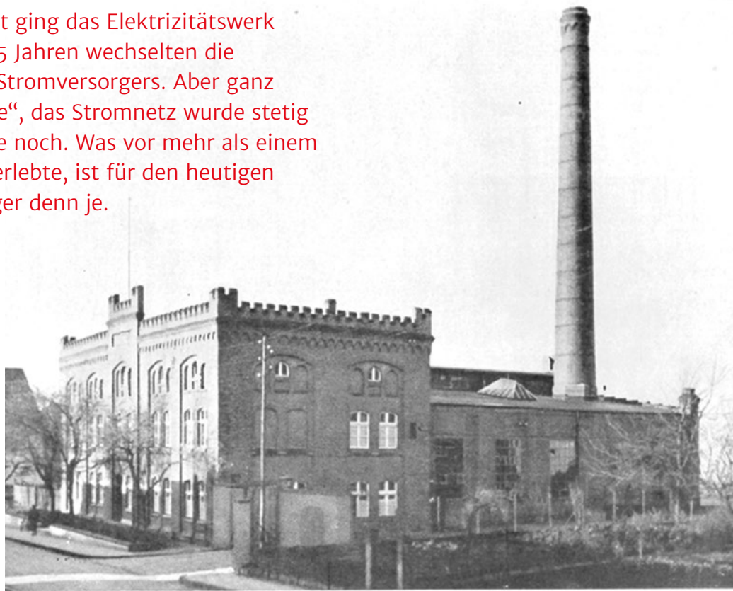
DAS ELEKTRIZITÄTSWERK AM ALDEGREVERWALL im Zustand nach 1908, die Maschinenhalle war auf annähernd die doppelte Länge vergrößert worden.
