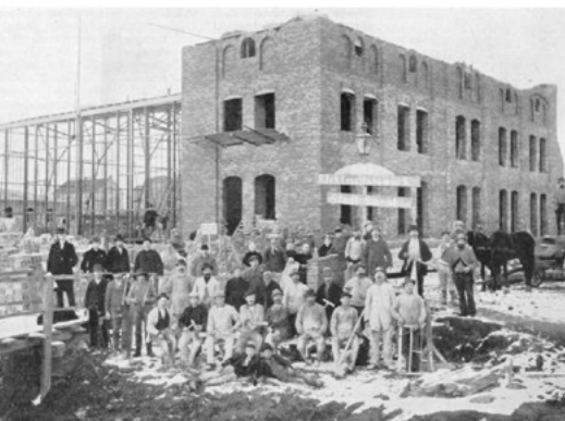
DAS ELEKTRIZITÄTSWERK AM ALDEGREVERWALL im Zustand nach 1908, die Maschinenhalle war auf annähernd die doppelte Länge vergrößert worden.
