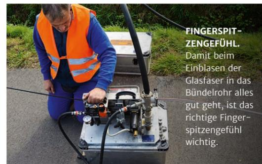
**FINGERSPITZENGEFÜHL.** Damit beim Einblasen der Glasfaser in das Bündelrohr alles gut geht, ist das richtige Fingerspitzengefühl wichtig.
